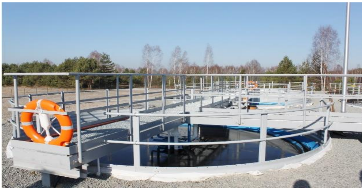
Zdj.1. Oczyszczalnia ścieków w Radomyślu nad Sanem [1]
