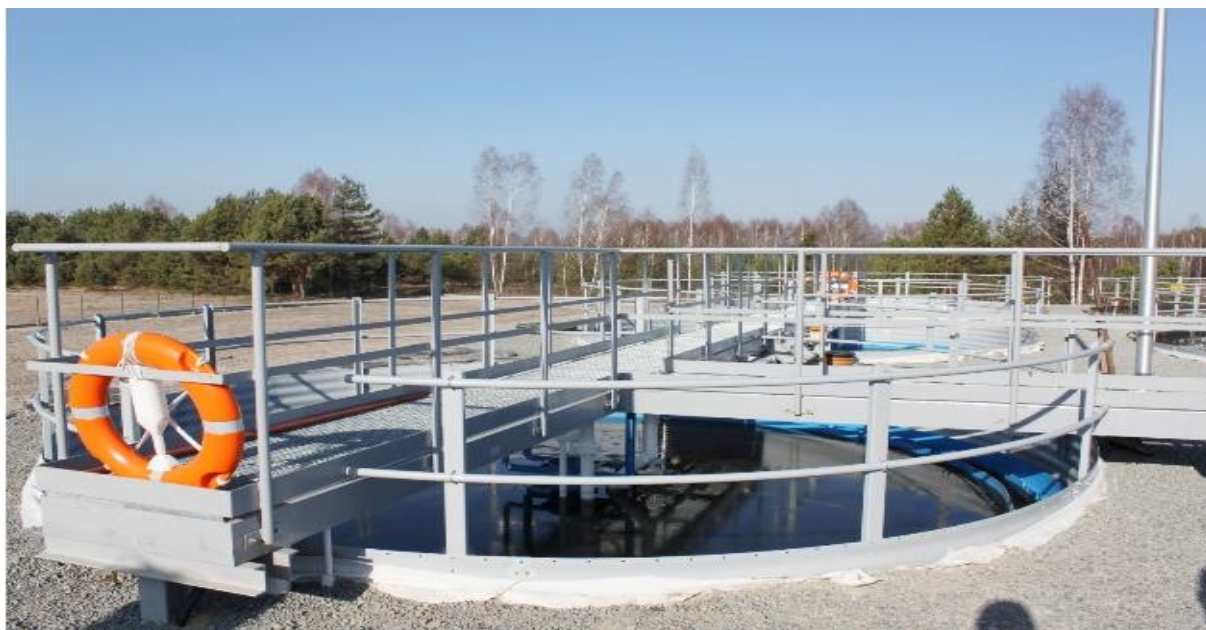
Zdj.1. Oczyszczalnia ścieków w Radomyślu nad Sanem [1]
