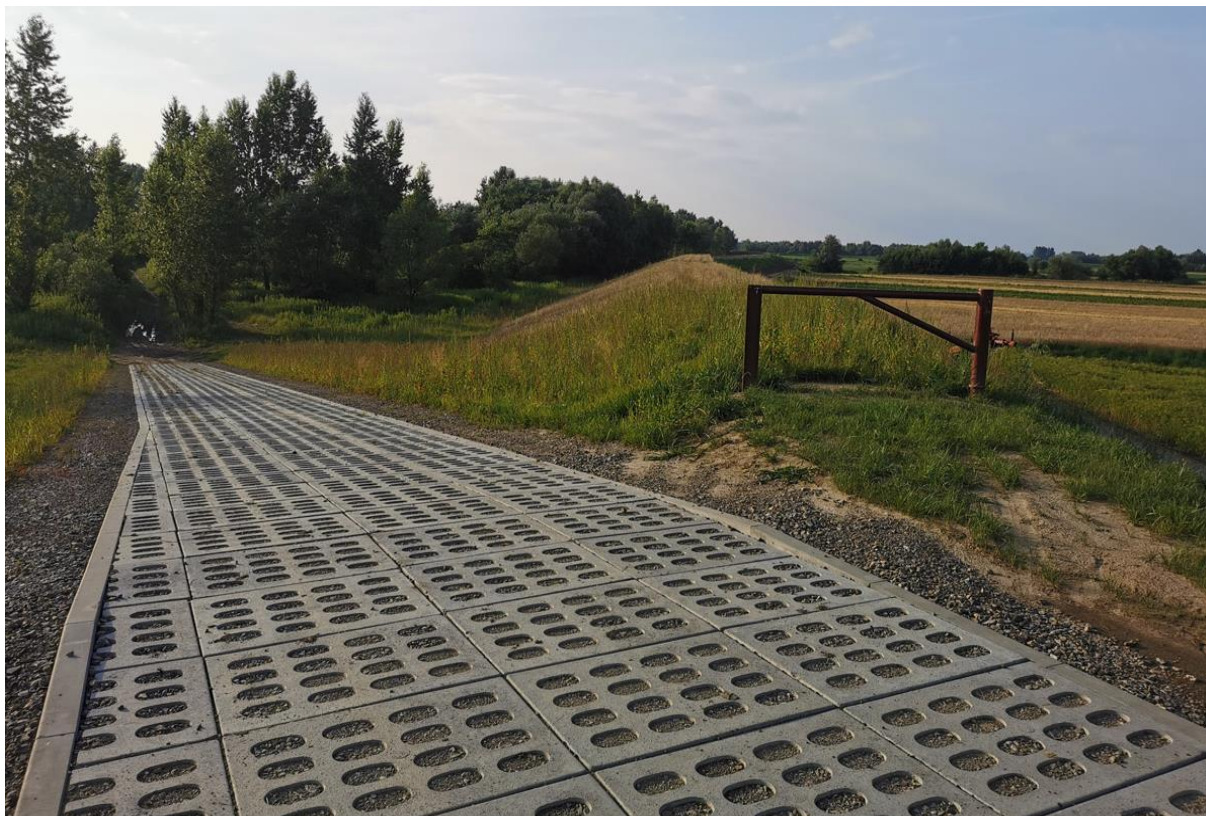
Zdj.4. Przebudowane wały przeciwpowodziowe [1]
