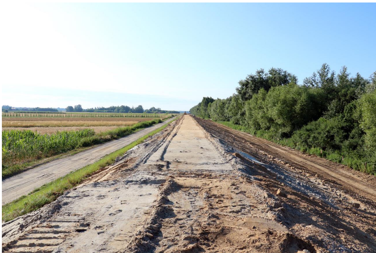
Zdj. 12. Postępujące prace na wałach w Gminie Radomyśl nad Sanem [6]
