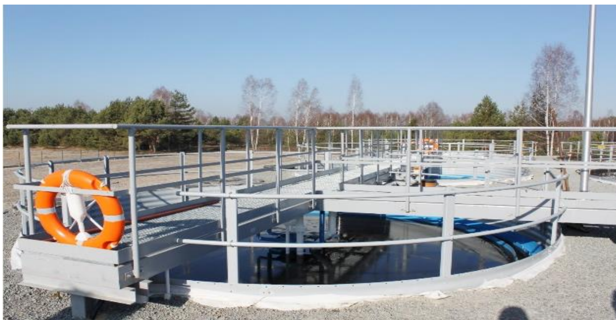
Zdj.4. Oczyszczalnia ścieków w Radomyślu nad Sanem [3]
